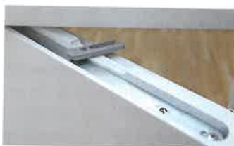
Der Einzugsdämpfer befindet sich eingefräst oben im Türblatt.
