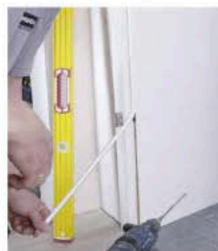
Schaum allein genügt hier nicht: die Zarge wird angeschraubt
